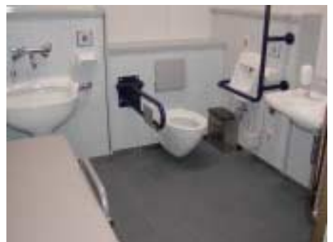
千里中央駅 多目的トイレ
