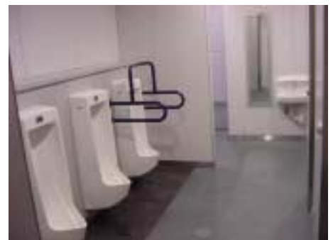
千里中央駅 トイレ完成写真
