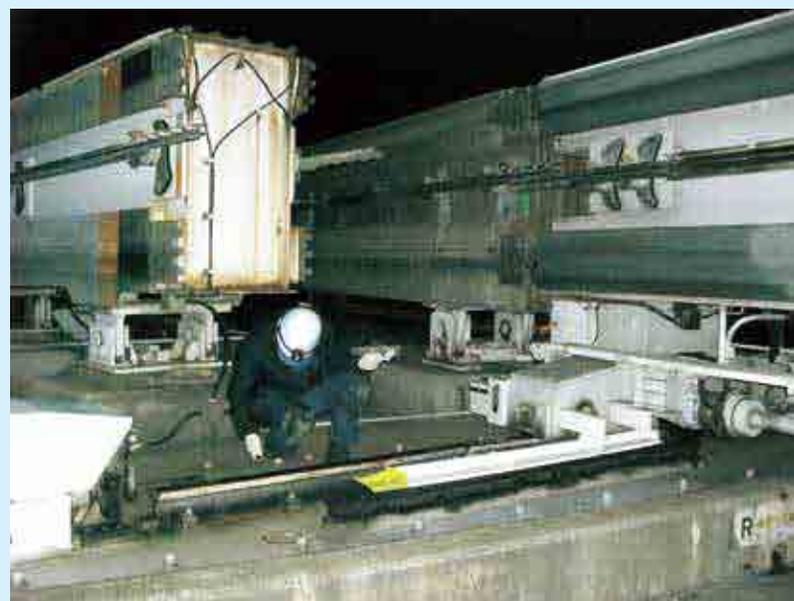
**分岐器**（一般の鉄道のポイントに相当する設備）
