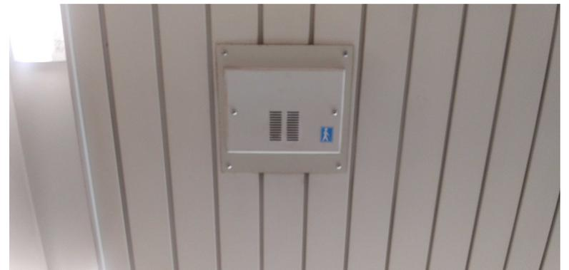
階段：ホーム上にある出口へ通じる階段位置を知らせるため、階段始端部の上部に設置しています。
