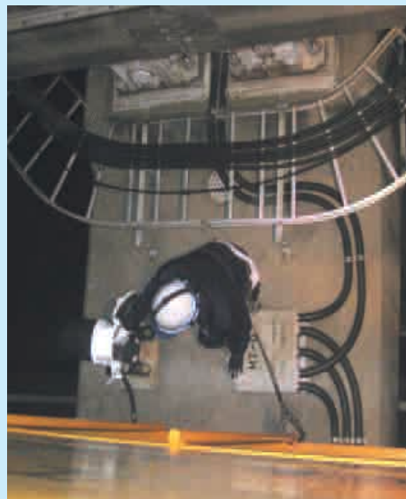
信号機の点検
