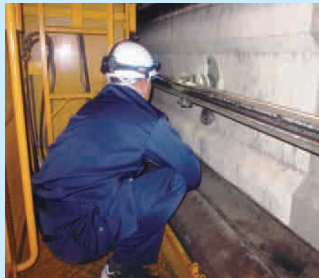
電車線の点検
