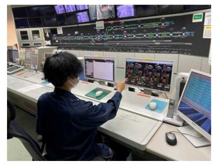
全ての変電所(5ヶ所)の機器が遠隔操作可能な電力管理システムを導入しています。
