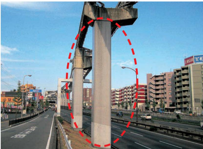
鋼板巻き立てによる支柱補強
