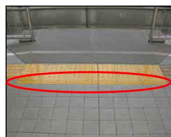
ホーム縁端警告ブロック
