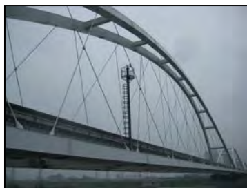
淀川橋梁風速計
