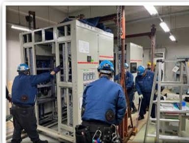
万博公園変電所更新工事
