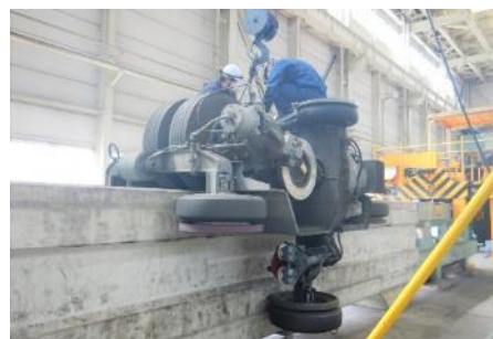
②台車吊り上げ
