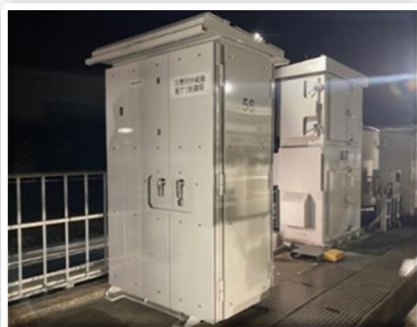
分岐器制御盤更新工事
