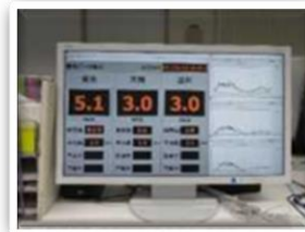
風向風速監視システム
