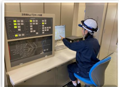
信号保安設備点検
