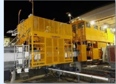
保守車両による点検
