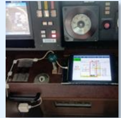
専用コンセントの設置
