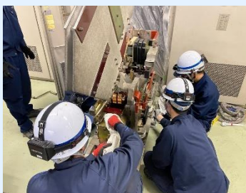
電力設備点検
