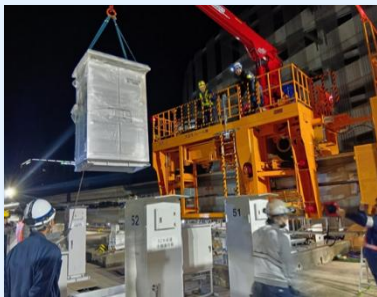
制御盤の更新状況
