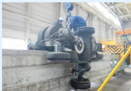
②台車吊り上げ
