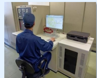
信号保安設備点検
