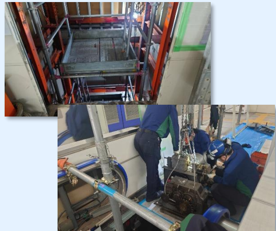
昇降機の更新状況
