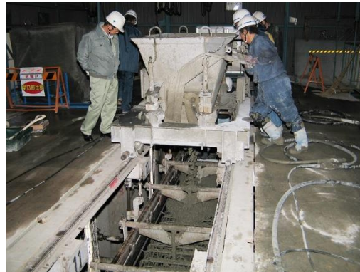
型枠へのコンクリート打込み
