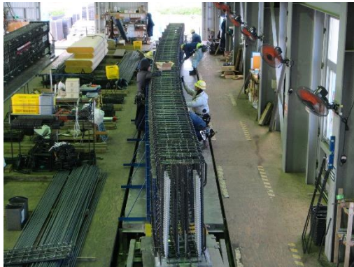
鉄筋の組み立て
