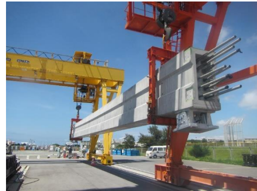
型枠を外した軌道桁
