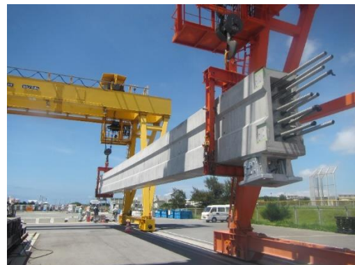
型枠を外した軌道桁
