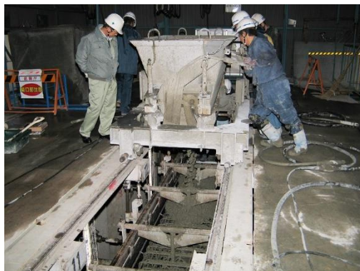
型枠へのコンクリート打込み
