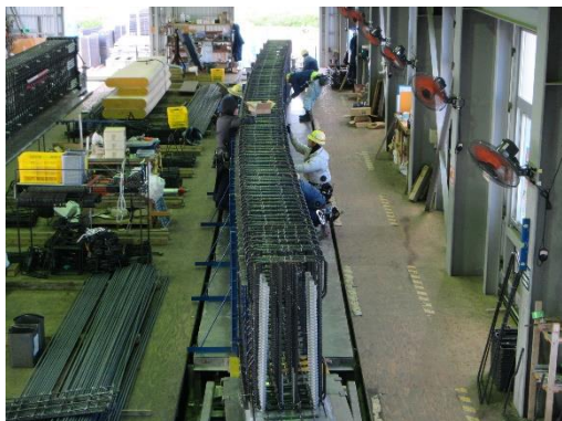
鉄筋の組み立て
