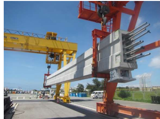
型枠を外した軌道桁
