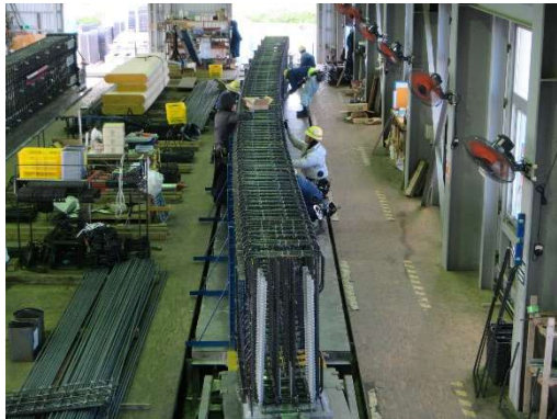
鉄筋の組み立て
