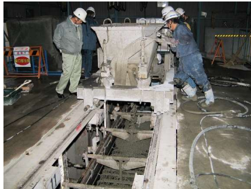
型枠へのコンクリート打込み
