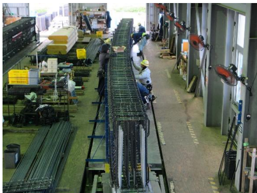
鉄筋の組み立て
