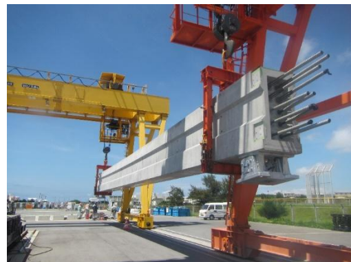
型枠を外した軌道桁
