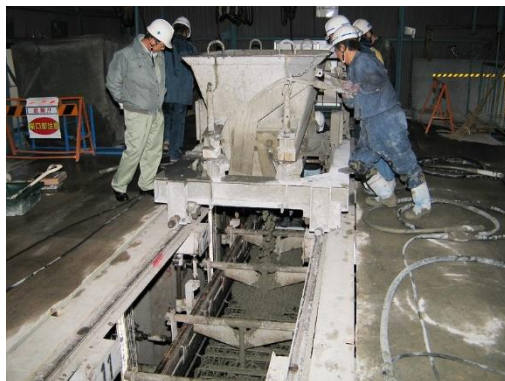
型枠へのコンクリート打込み
