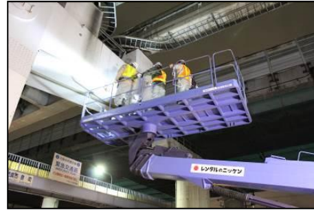
高所作業車による点検
