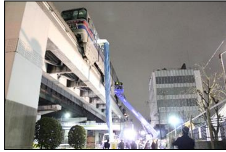
高所作業車による点検
