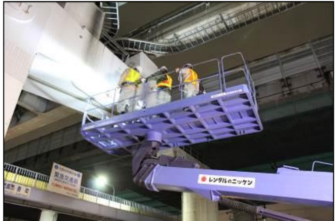
高所作業車による点検
