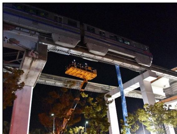
高所作業車を使用した点検
