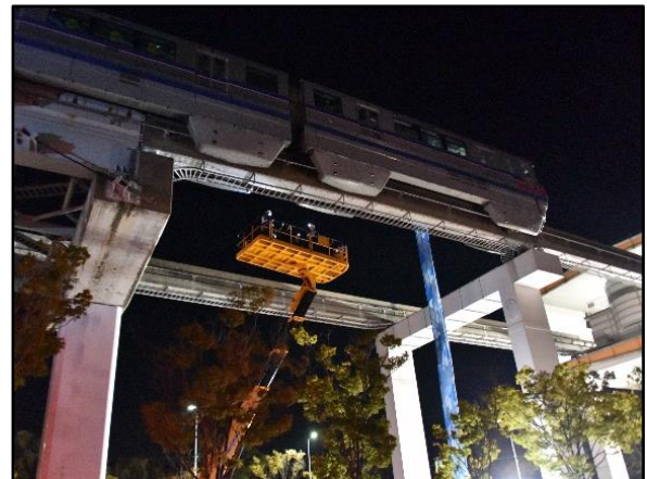
高所作業車を使用した点検
