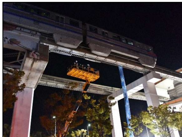
高所作業車を使用した点検
