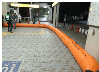
水のう型簡易膨張ダムを設置
